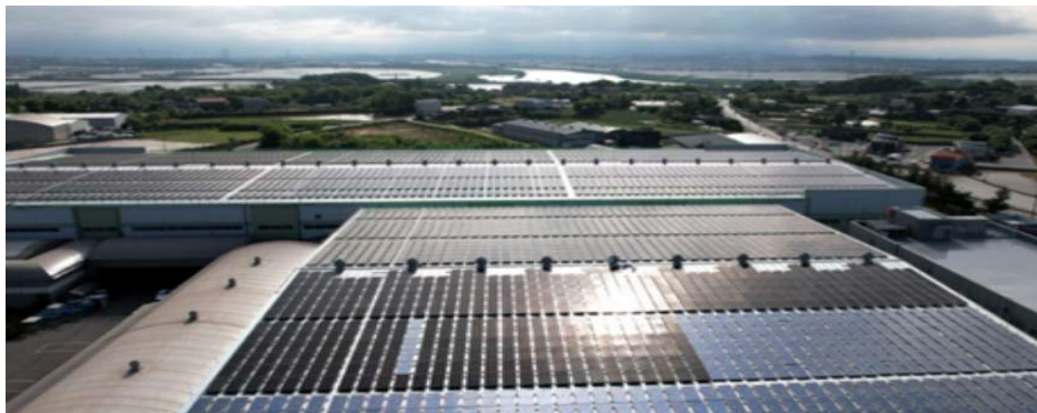
태양광 발전설비 운영 현황
